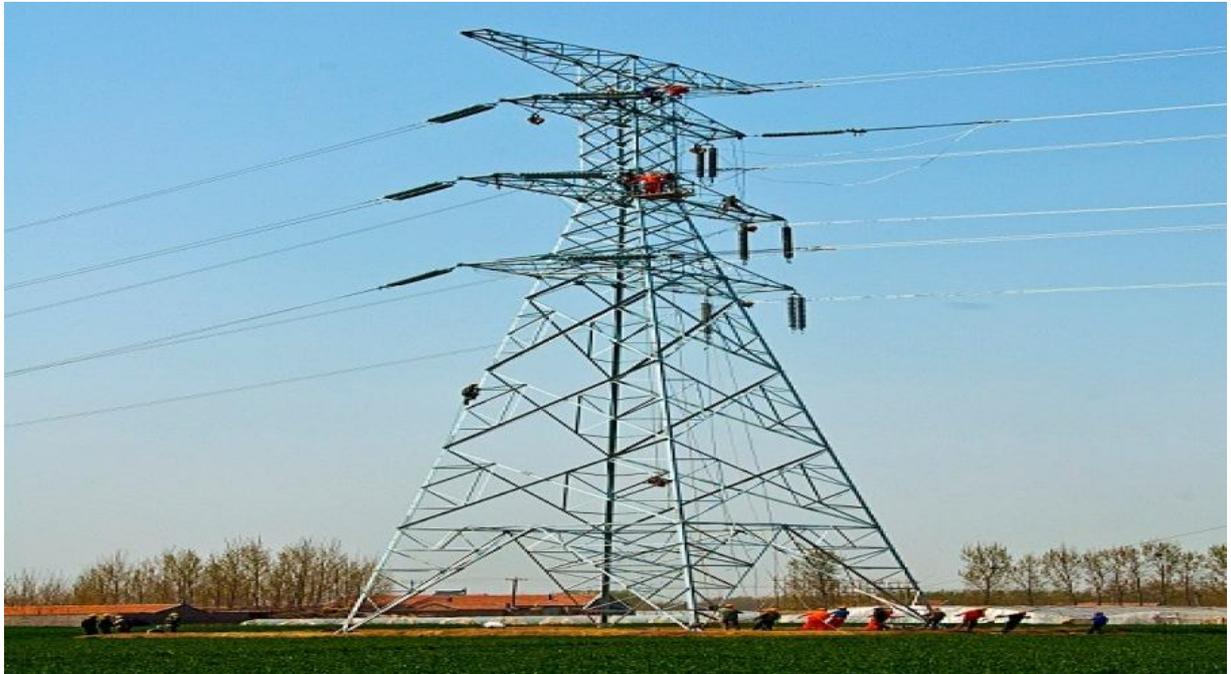
公司在湖南电力承包的线路塔防腐工程。
