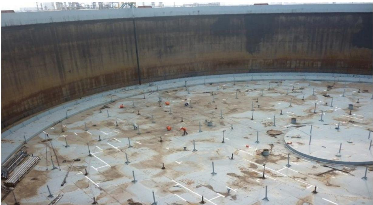
十万立大罐浮船修复防腐施工。
